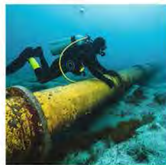
해저 케이블 설치
