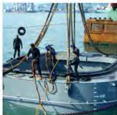
수중 HABITAT 설치
